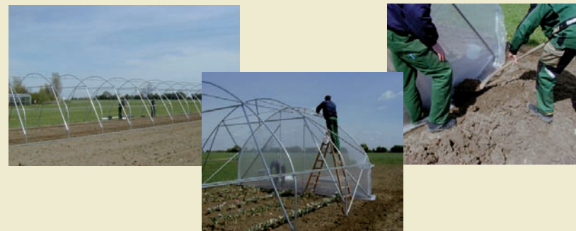
Opsætning af tunnel (opsætning af buer og sidelister, påhæftning af endenet til sikring af fuld ventilation, jorddækning af sidenet).
